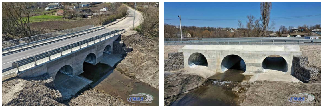
Рис.2. Ремонт аварійного мосту с. Дзигівка, Вінницька область
