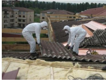
Рис.2. Захист персоналу при демонтажі шиферу з дахів будівель
