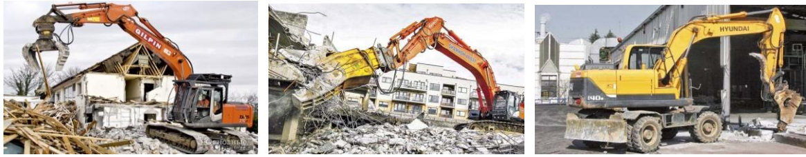
Рис.2. Екскаватори з робочими органами для зносу будівель, розділення і сортування будівельних відходів.
