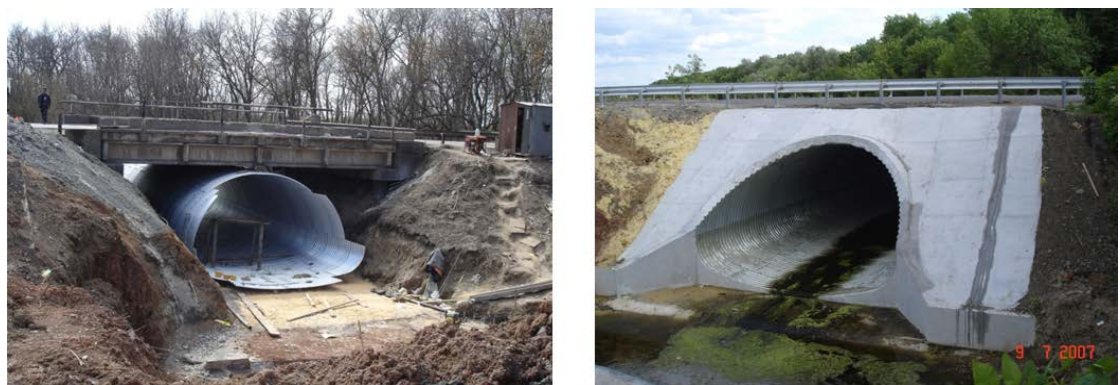
Рис.3. Гільзування мосту на автомобільній дорозі Знамянка – Луганськ – Ізварине
