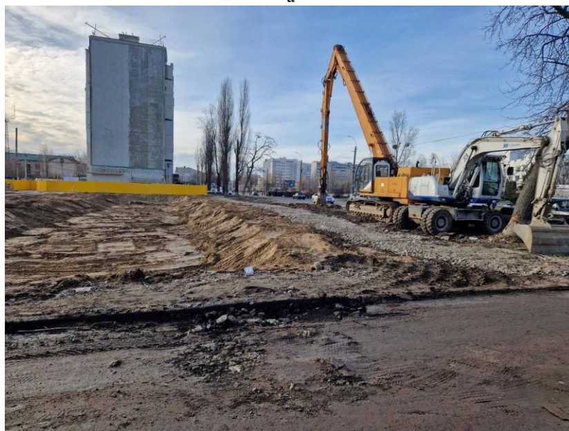
Рис. 1 Виконання демонтажних робіт екскаватором з гідравлічними ножицями: а – схема виконання робіт; б – результат демонтажних робіт.
